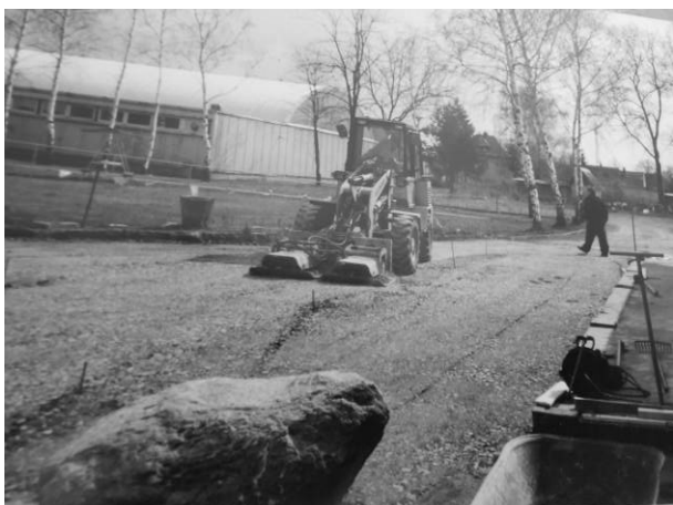
Pflasterarbeiten vor dem Sportlerheim
