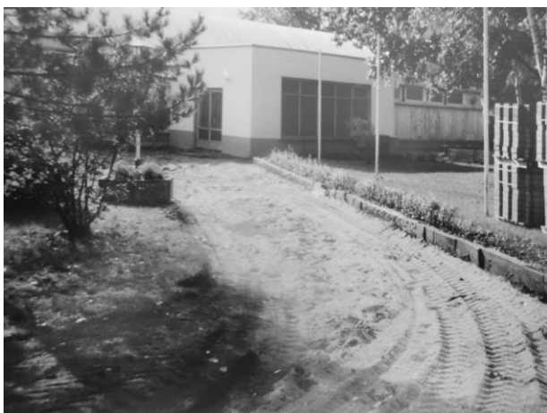
Pflasterarbeiten vor der Turnhalle
